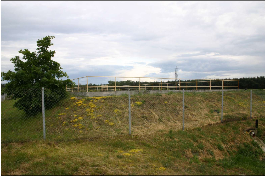
Oczyszczalnia ścieków w Koronowie
