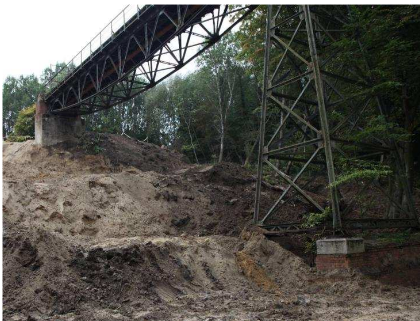
Rys. 13. Podpory przewidziane do monitorowania przemieszczeń.
