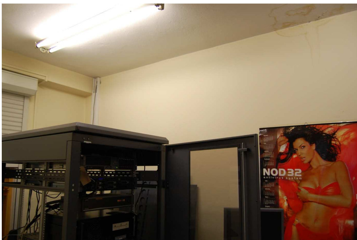
Fot. nr 8 ogólny stan pomieszczenia i ich zagospodarowania
