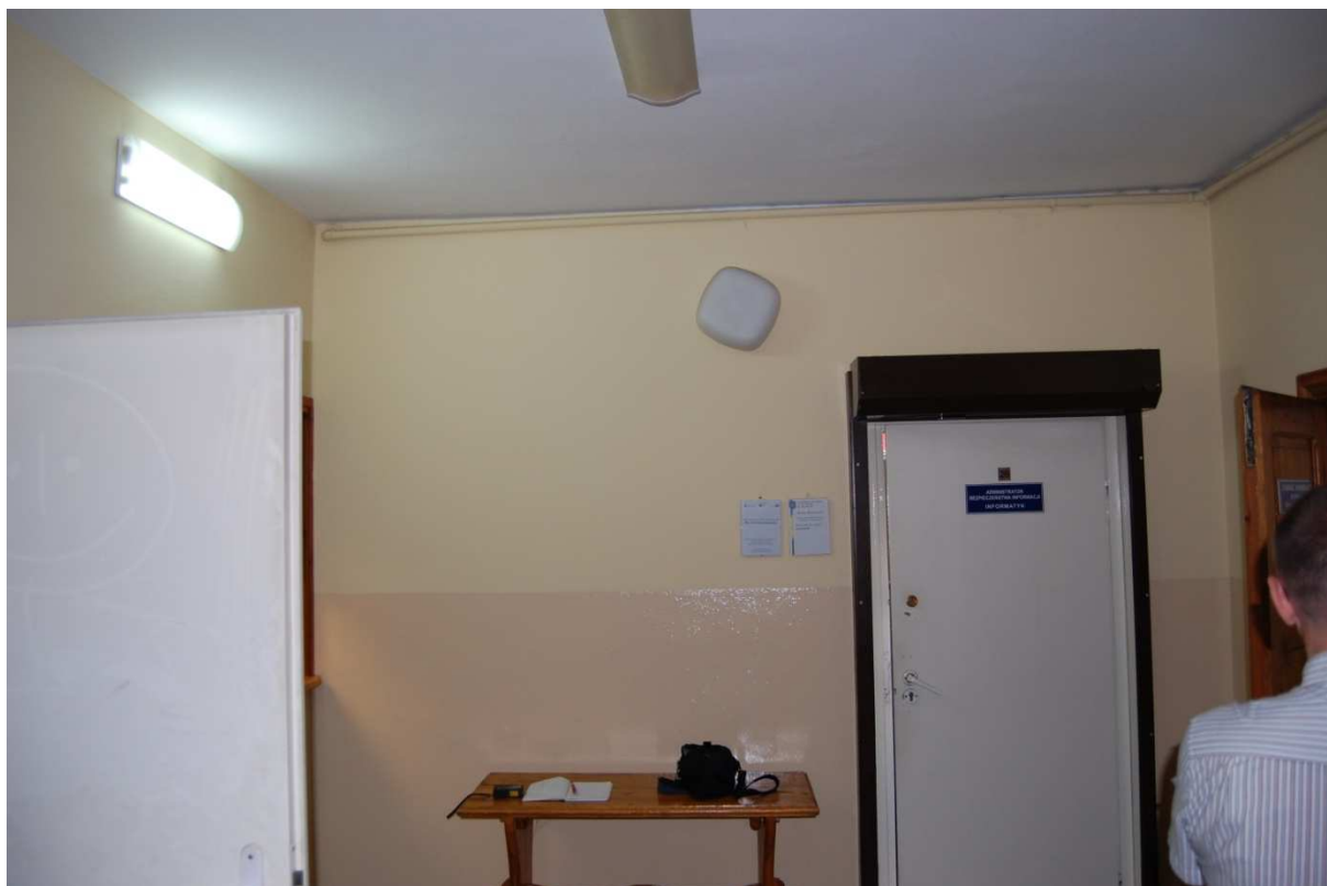
Fot. nr 3 ściana północna widok z zewnątrz
