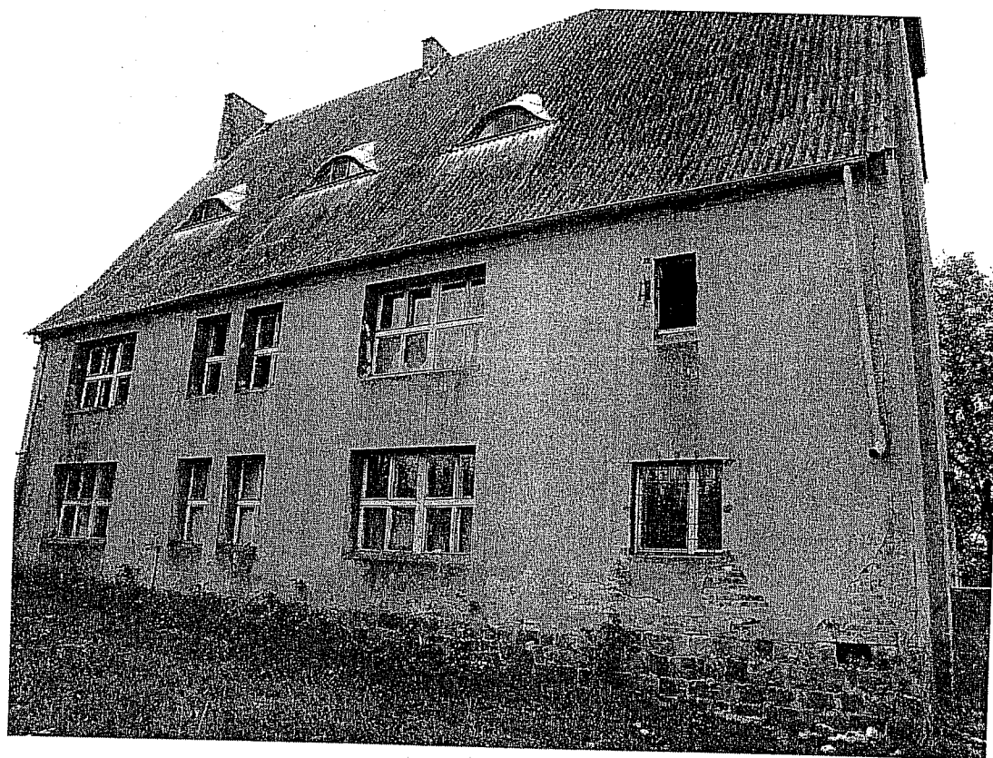
rys. 1. Widok ogólny budynku - elewacja północna.
