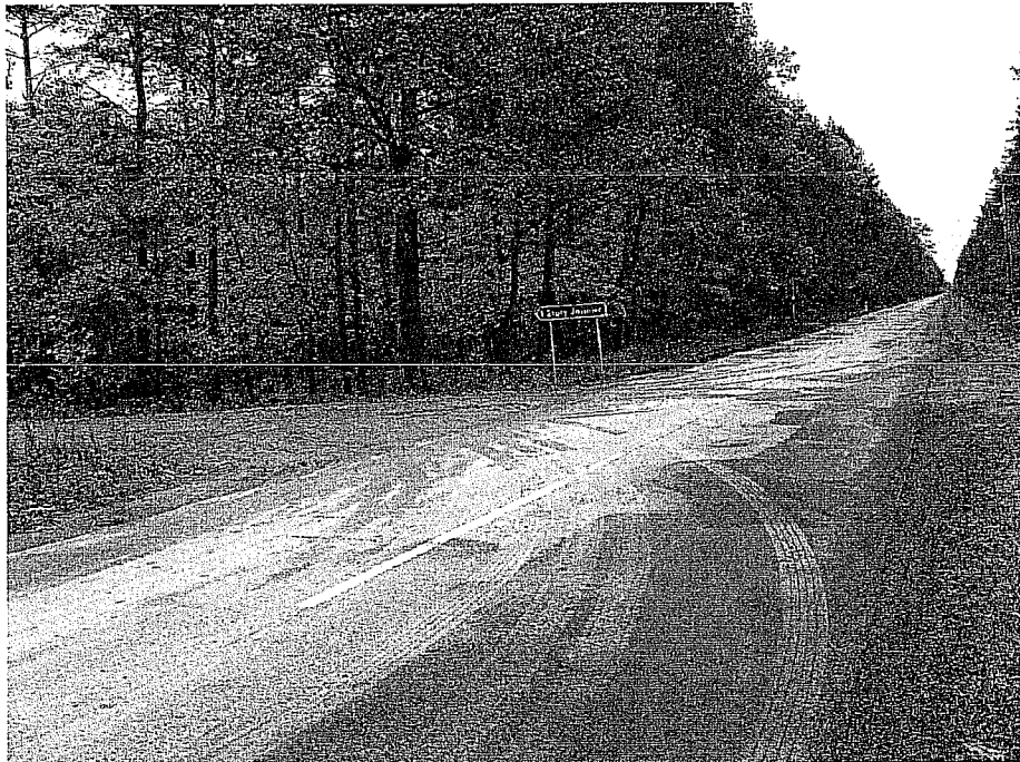
Miejsce skrzyżowania drogi gminnej z drogą krajową - widok w kierunku miejscowości Włóki
