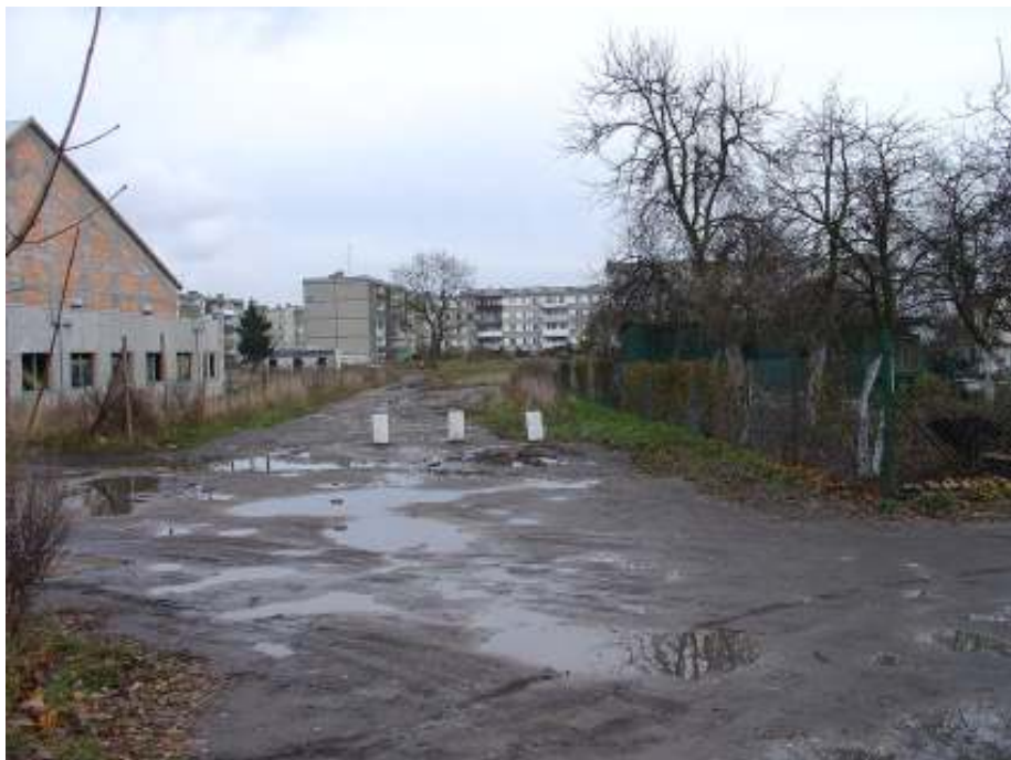
Droga przy południowej ścianie dokumentowanej Hali
