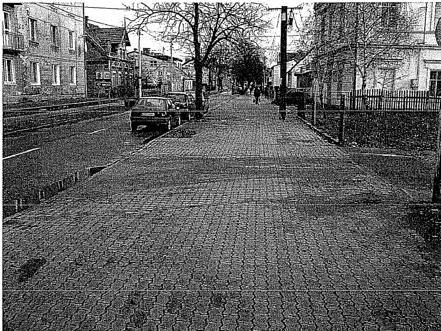
Miejsce skrzyżowania projektowanej drogi z ulicą Dworcową
