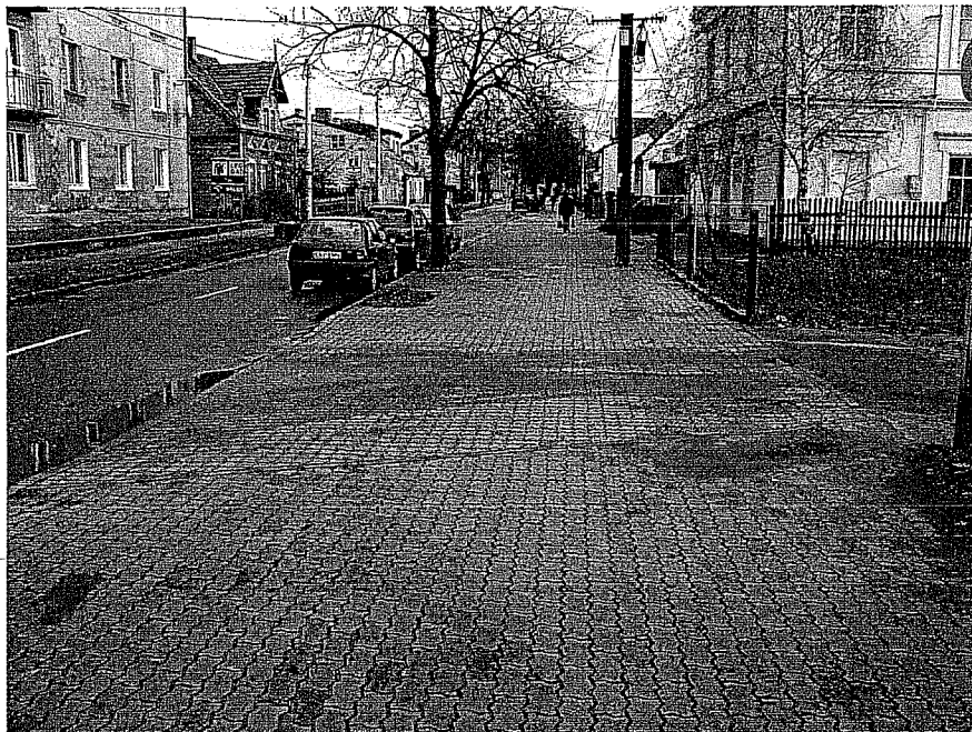
Miejsce skrzyżowania projektowanej drogi z ulicą Dworcową
