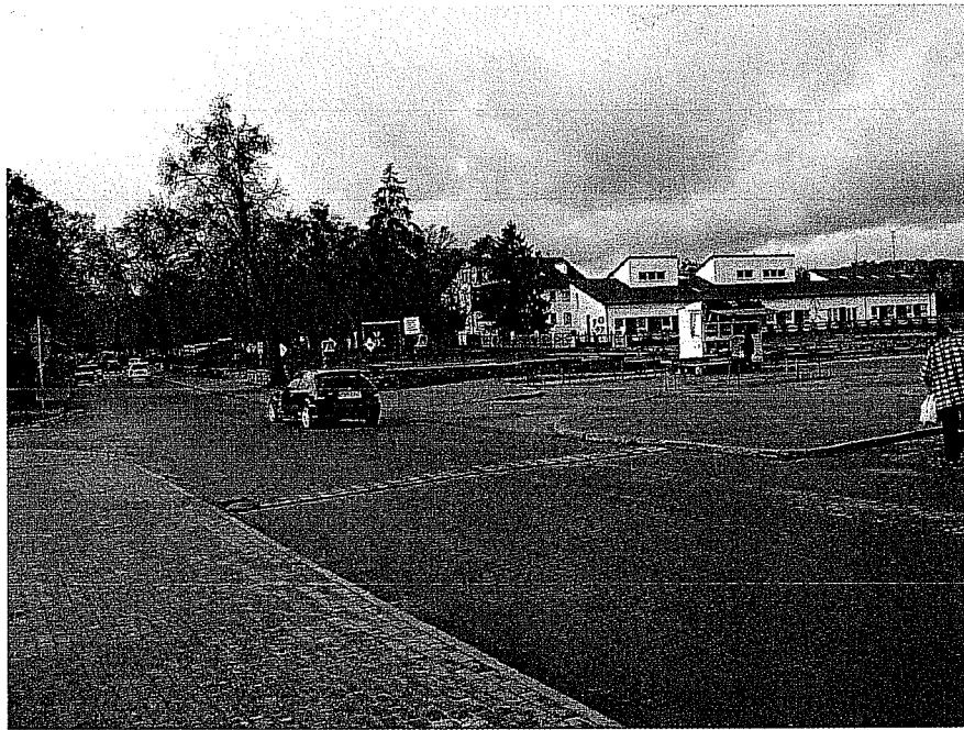
Miejsce skrzyżowania projektowanej drogi z ulicą Witosą
