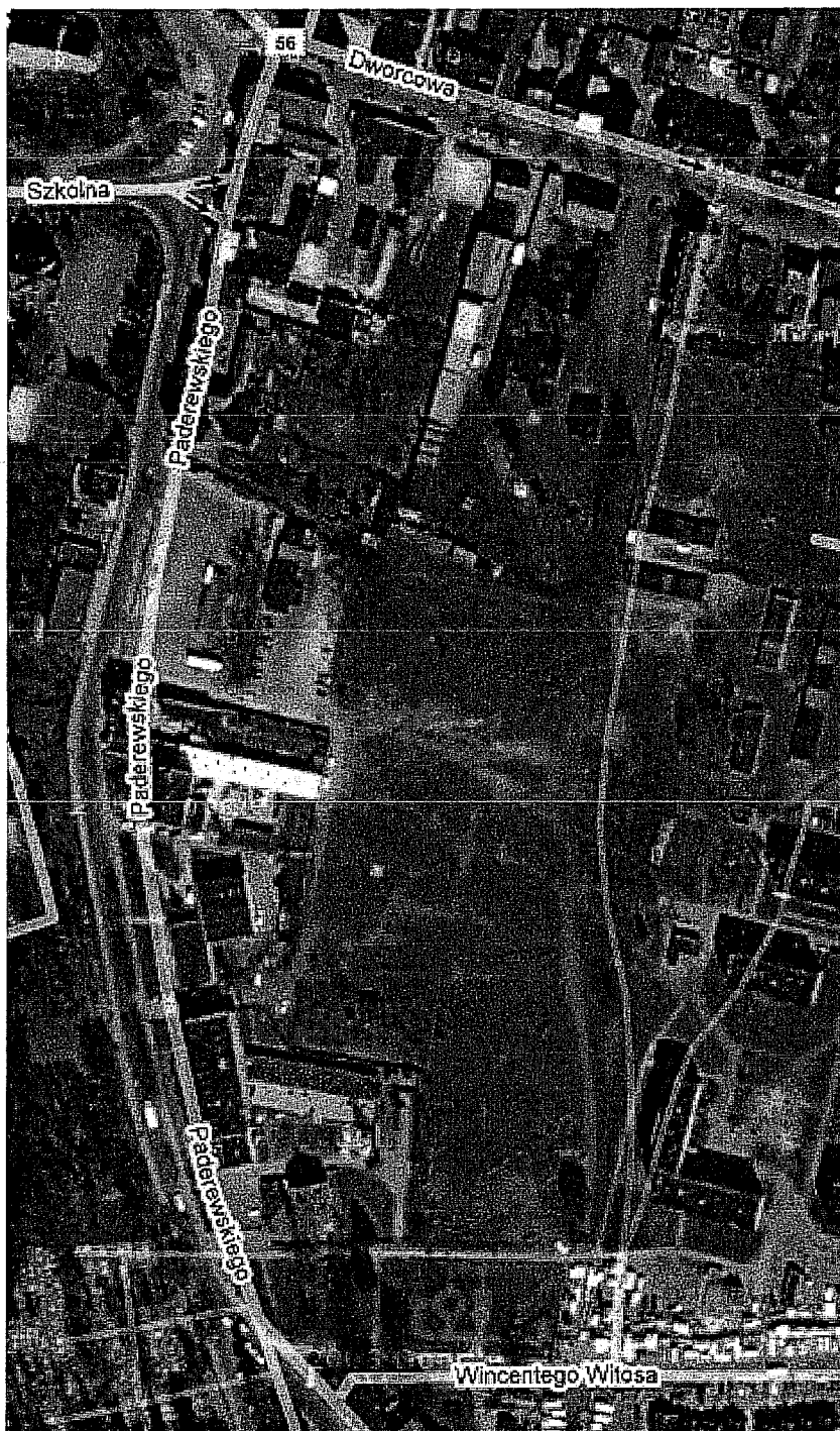
Zdjęcie satelitarne terenu przewidzianego pod budowę drogi od ulicy Dworcowej do ulicy Witosa
