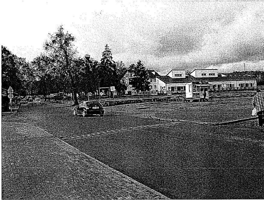
Miejsce skrzyżowania projektowanej drogi z ulicą Witoska
